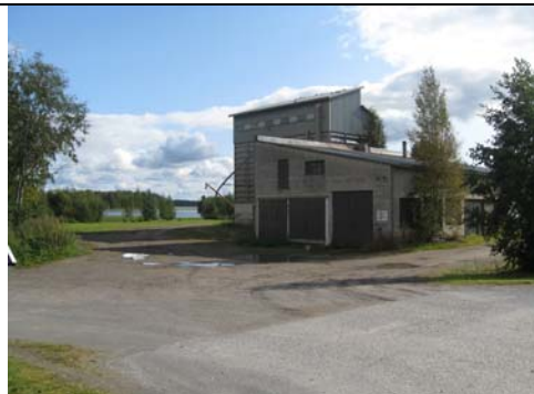
Kuva 7. Lappajärven osuuskaupan rakennus.
